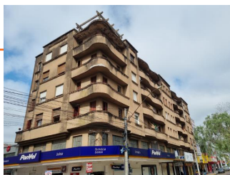
FIGURA 14 - Edifício Salim Kalil | Fonte: google earth
