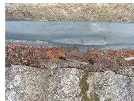
FIGURA 6 - Calha enferrujada e com furos | Fonte: Dados produzidos pelo autor (2021)
