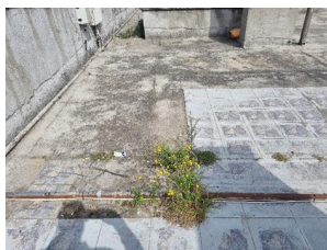
FIGURA 17 - Vegetação na laje de cobertura | Fonte: Dados produzidos pelo autor (2021)
