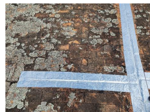
FIGURA 18 - Manta asfáltica sobre junta de dilatação | Fonte: Dados produzidos pelo autor (2021)
